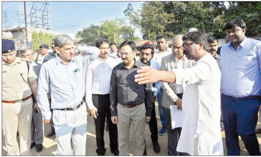
कांटाटोली चौक पहुंच कर योगदा सत्संग आश्रम (सिरमटोली)-कांटाटोली-कोकर फ्लाईओवर निर्माण कार्य की प्रगति का निरीक्षण करते मुख्यमंत्री हेमंत सोरेन। साथ में हैं मुख्य सचिव सुखदेव सिंह, प्रधान सचिव राजीव अरुण एक्का, सचिव विनय कुमार चौबे।
