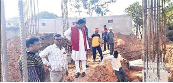
निर्माणधीन रेफरल अस्पताल के भवन का निरीक्षण करते विधायक कोचे मुंडा।
