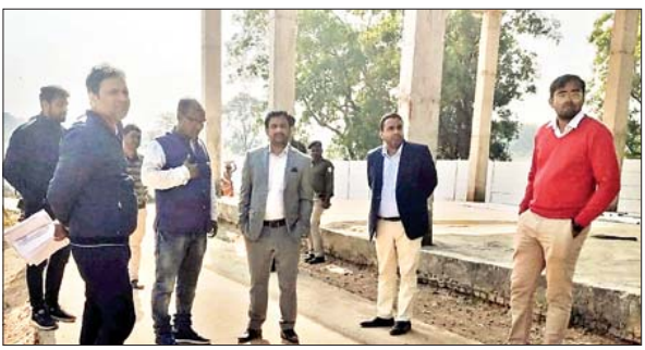
निर्माणधीन खुदी शहरी जलापूर्ति का निरीक्षण करते डीसी शशि रंजन व अन्य।
