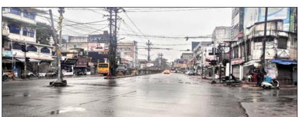
मुश्किल शहरी जलापूर्ति योजना के तहत पाइप बिछाने के लिए शहर के आजाद रोड और करी रोड के चौधरी मोहल्ला में पक्की सड़क की खुदाई और ऊपर से हो लगातार बारिश के कारण शहर के यह दोनों प्रमुख पथ कीचड़ में तब्दील हो गये हैं। स्थिति यह हो गयी है कि इन सड़कों पर लोगों को पैदल गुजरना भी मुश्किल हो गया है। धान-मडुवा की फसल को भारी नुकसान मिचौंग तूफान के कारण तीन दिनों
