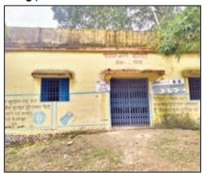
पंचायत भवन बलियारी।
