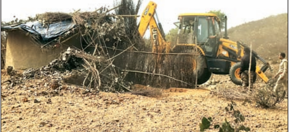
जंगल में बने अवैध घर को प्रशासन की मौजूदगी में जेसीबी से किया जा रहा नष्ट।
