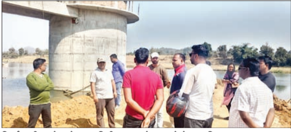
निर्माणाधीन इंटेक वेल का निरीक्षण करते झामुमो नेता, मुखिया व अन्य।
